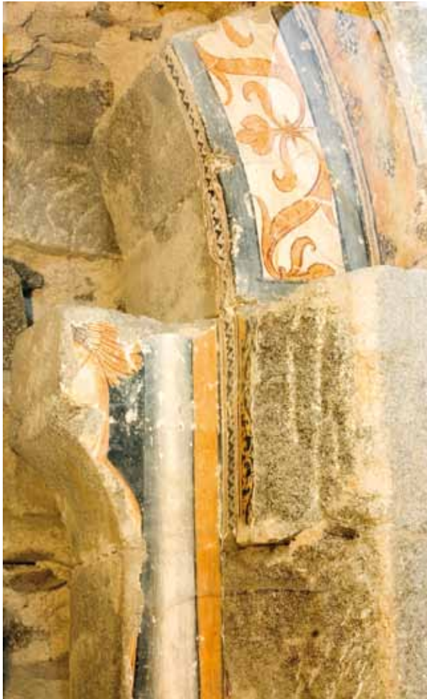
Mosteiro de Santa Maria de Pombeiro. Parede sul da nave. Motivos decorativos.
